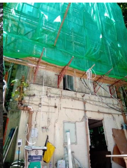
圖中建築物 (工程進行中)
